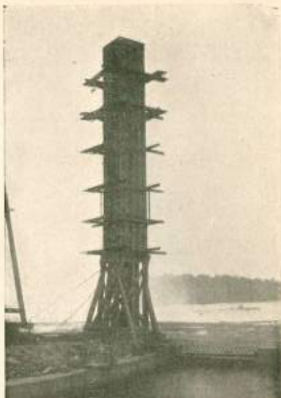
Come la colonna fu fabbricata.
