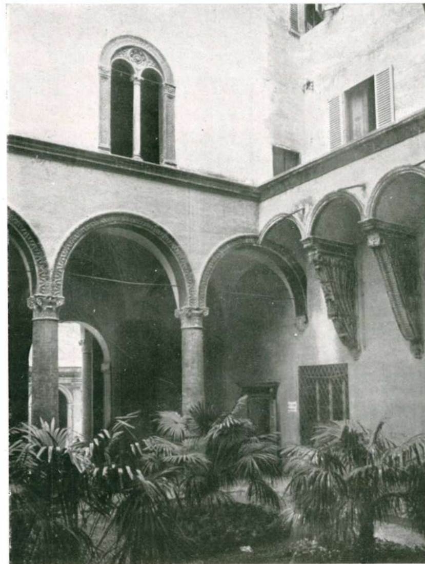
Palazzo Ghisilardi. (Lato settentrionale del cortile).
