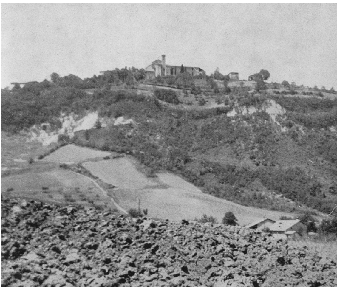
L'Abbazia di Monteveglio
