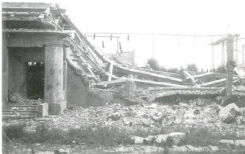
- Crevalcore: la sottostazione di trasformazione dell'energia elettrica della ferrovia Bologna-Verona, colpita dal bombardamento aereo degli Alleati, il 3 luglio 1944.
