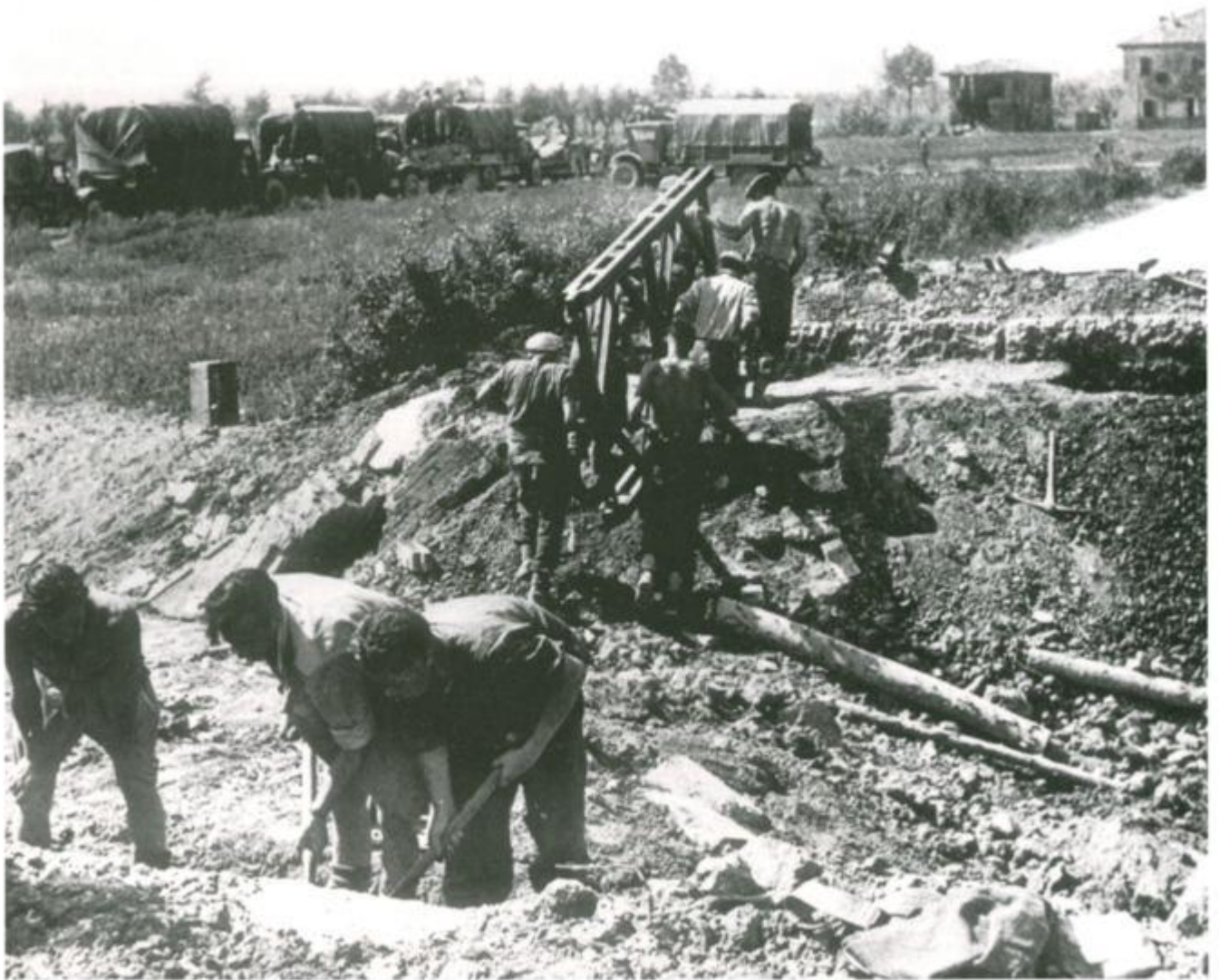
- Genieri neozelandesi costruiscono un ponte Bailey sul torrente Quaderna al posto di quello in pietra fatto saltare dai tedeschi in ritirata, fra Medicina, Budrio e Castenaso.
