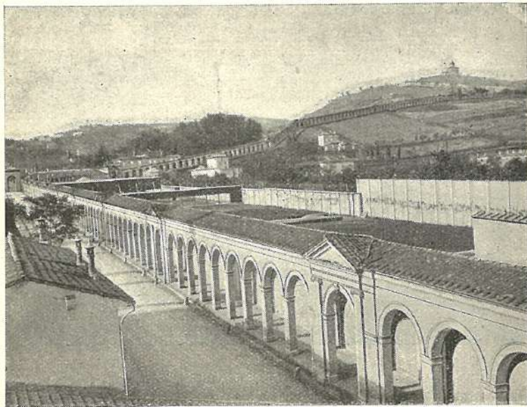
Porticato che conduce alla Certosa.
