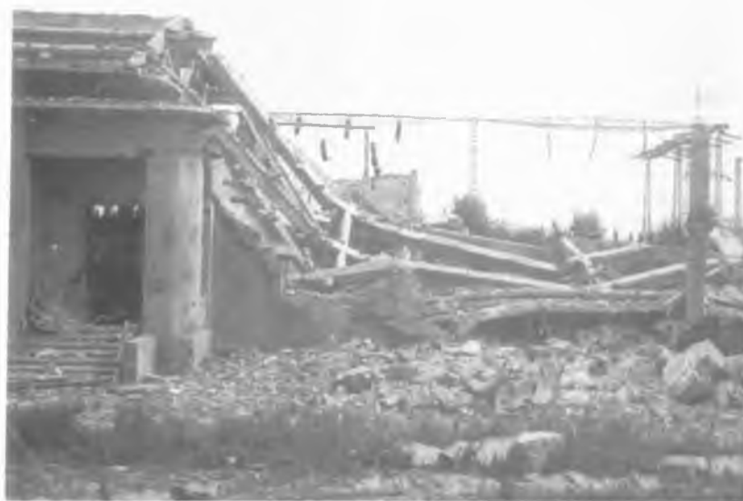
- Crevalcore: la sottostazione di trasformazione dell'energia elettrica della ferrovia Bologna-Verona, colpita dal bombardamento aereo degli Alleati, il 3 luglio 1944.
