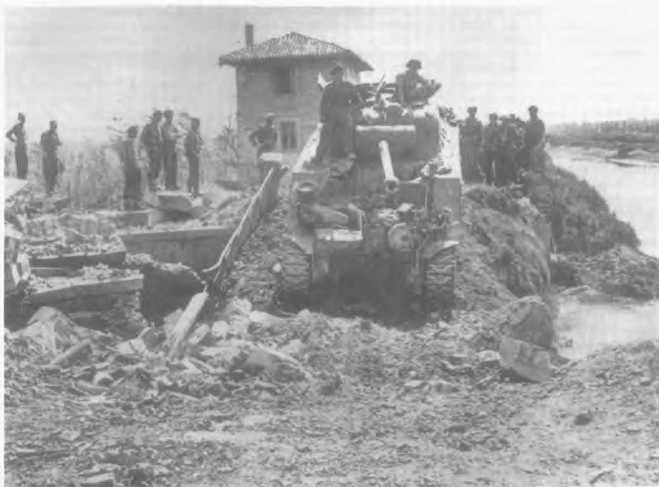
- Un carro armato supera le rovine della torre del Castello di Bentivoglio abbattuto con mine dai tedeschi a Ponte di Poledrano, sulla via di Saliceto che costeggia il canale Navile (IWM).
