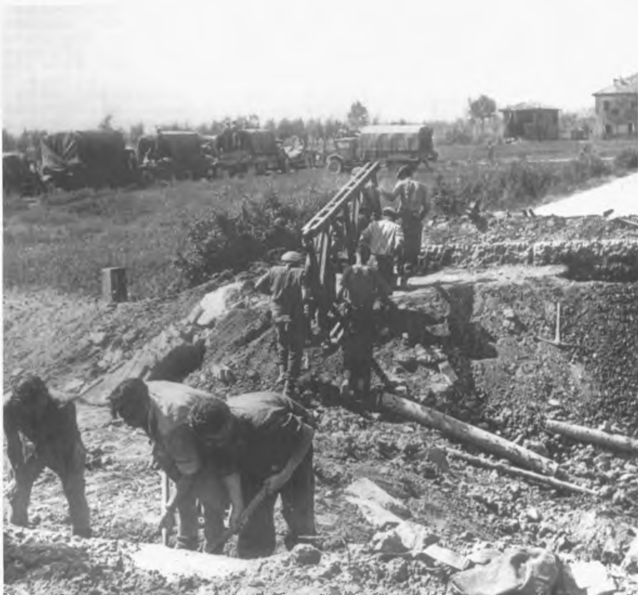
- Genieri neozelandesi costruiscono un ponte Bailey sul torrente Quaderna al posto di quello in pietra fatto saltare dai tedeschi in ritirata, fra Medicina, Budrio e Castenaso.
