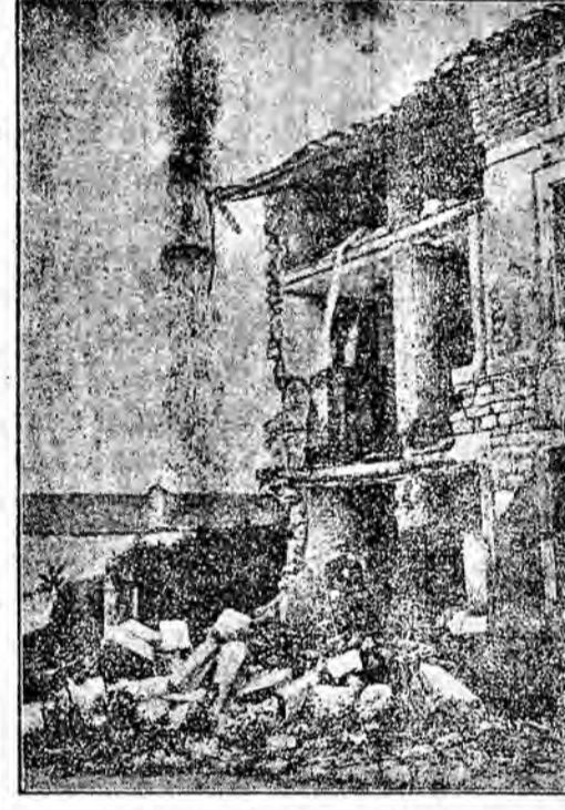
Ciò che resta di un villaggio nella zona del bombardamento
