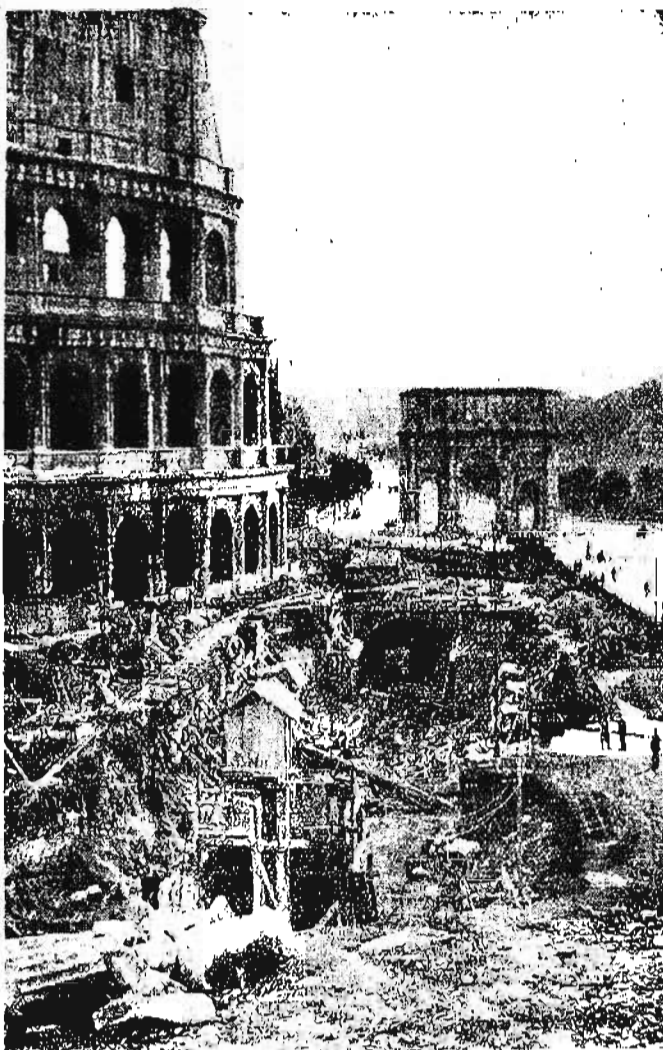
ROMA MUSSOLINIANA - Lo stato dei lavori per la costruzione della galleria sul Piazzale Romolo e Remo che farà parte della grande ferrovia sotterranea per l'E. 42
