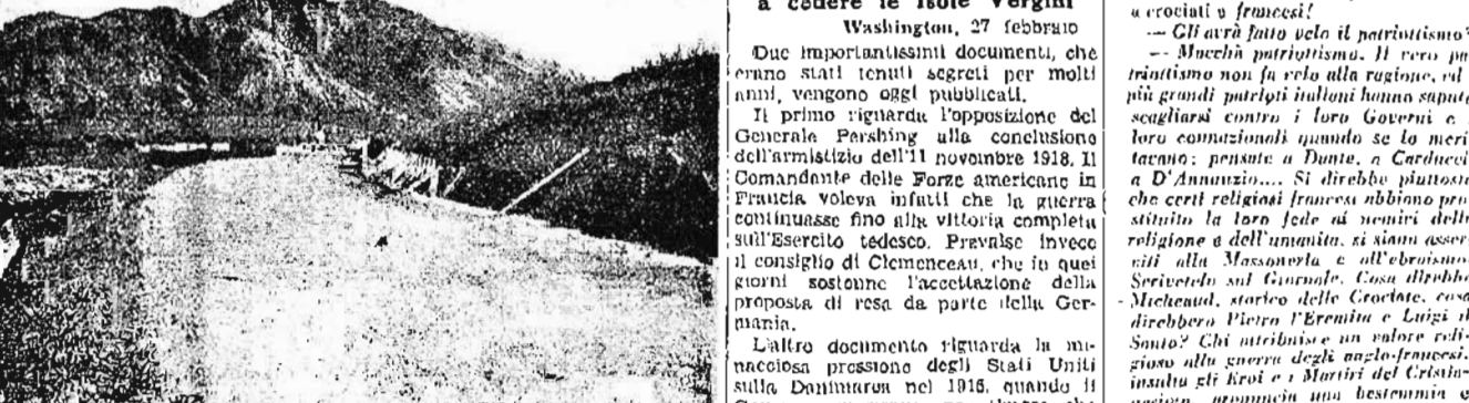
LA RINASCITA DELL'ALBANIA - Un tratto asfittato dell'autostrada Tirana-Durazzo in corso di costruzione
